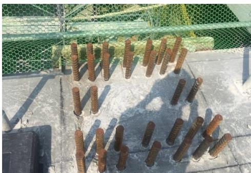
圖 R9.3 預鑄特殊結構牆工法之接合用金屬配件及預鑄特殊抗彎矩構架工法之接合用鋼筋
