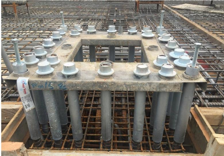
圖 R9.4 接合用鋼筋之定位板照片
