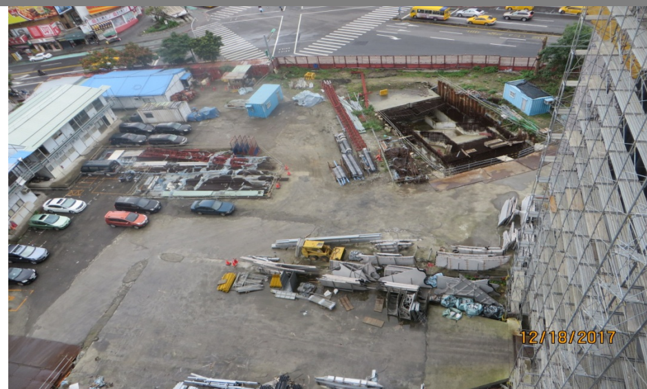
1F地下連通道及東北向現況
