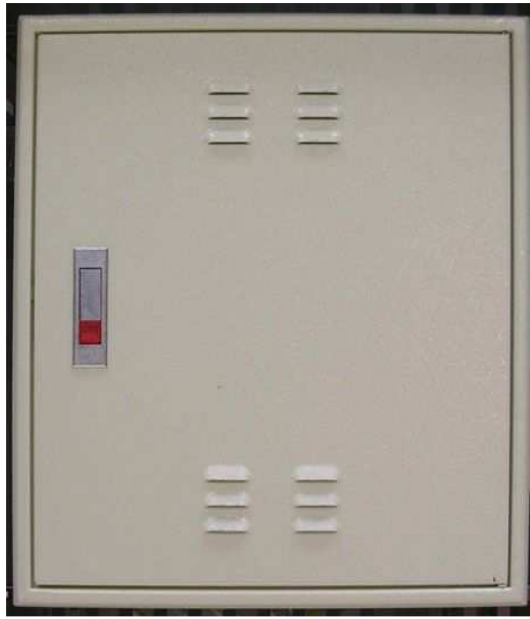
圖12-1 宅內配線箱箱門通風設計示意圖
