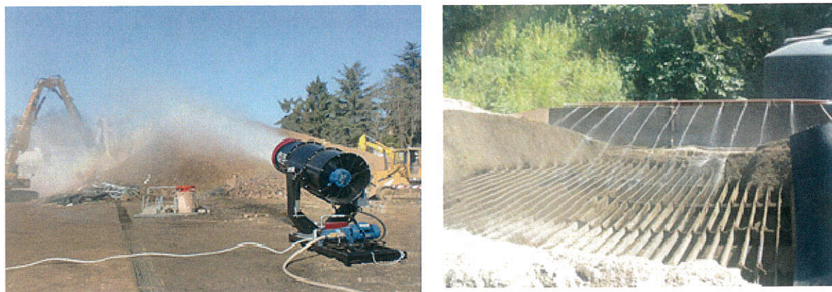
圖 35、裝卸作業灑水保持濕潤
