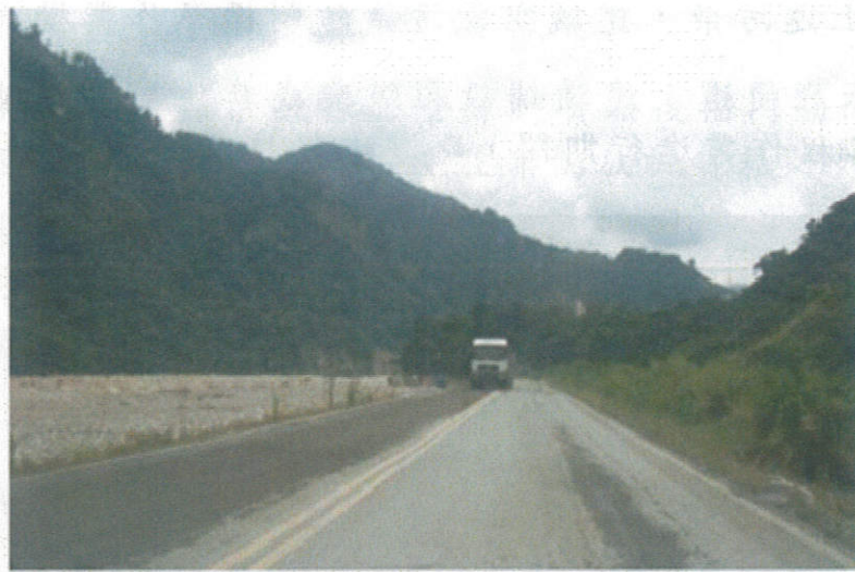
圖 10、鋪設瀝青混凝土
