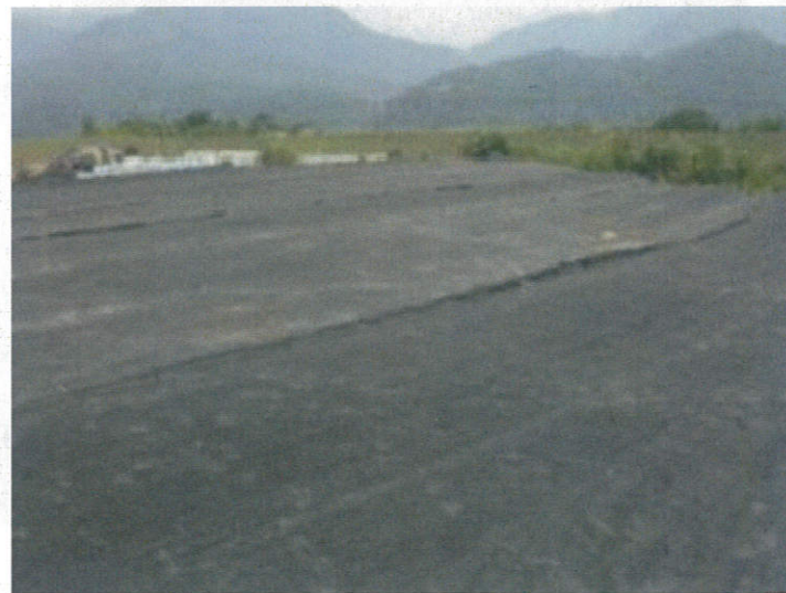
圖 15、裸露地覆蓋防塵網
