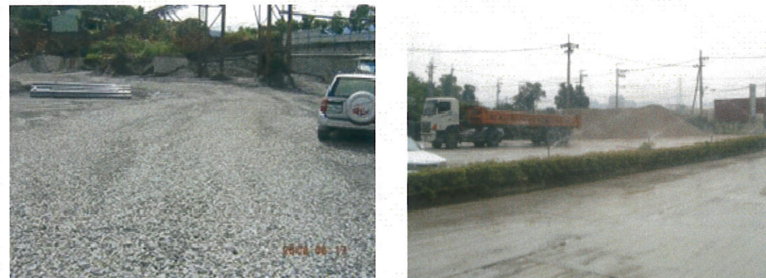
圖 33、堆置區鋪設粗級配並灑水濕潤
