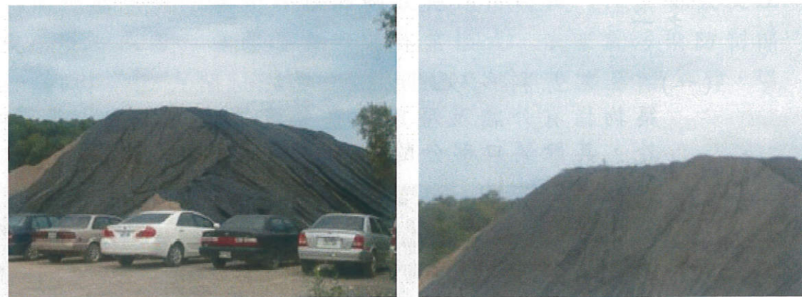
圖 22、以防塵布或防塵網覆蓋堆置物
