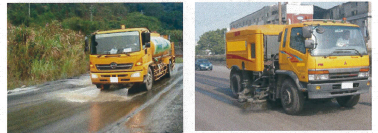
圖 13、工區周邊道路洗掃
