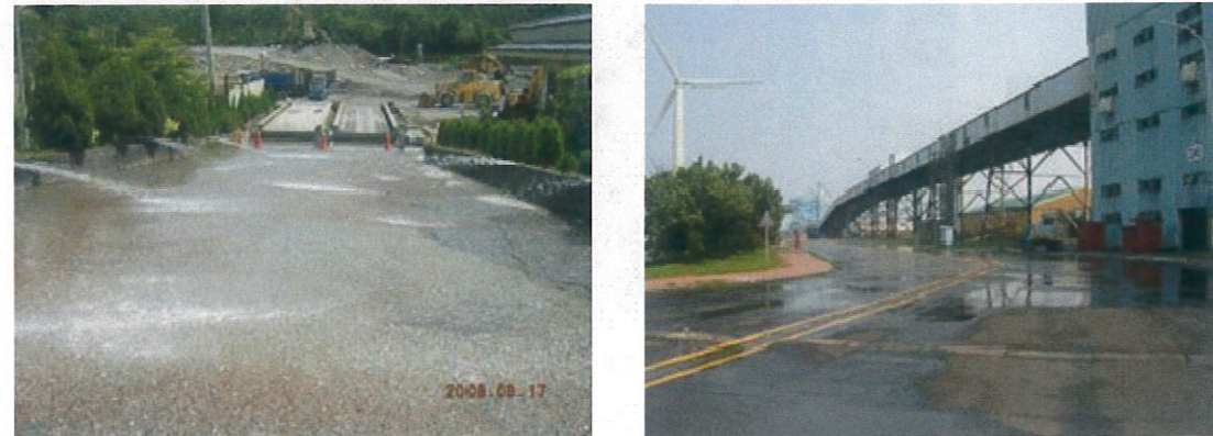
圖 32、砂石車行駛路徑鋪設混凝土或瀝青混凝土
