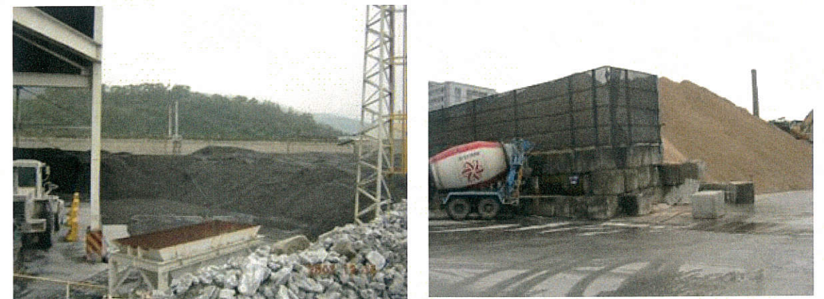
圖 21、堆置區四周設置阻隔牆
