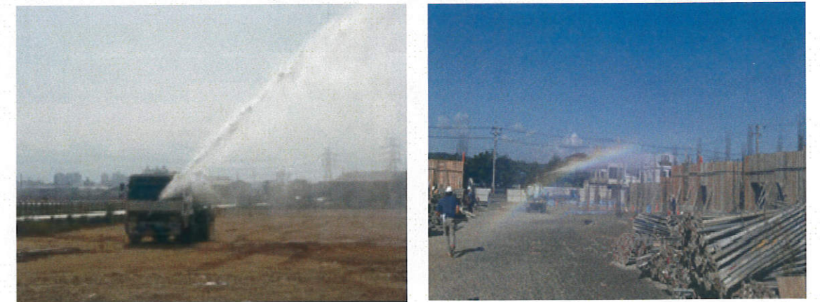
圖 18、裸露地壓實配合灑水
