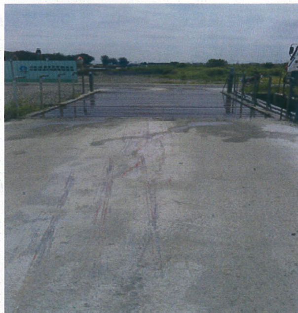
圖 11、洗車台連接道路鋪設混凝土
