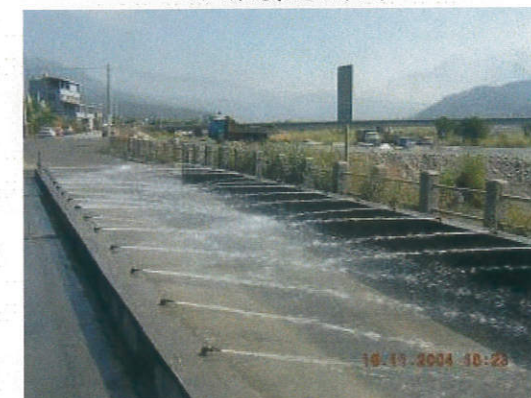
洗車平台-混凝土鋪設之洗車水槽
