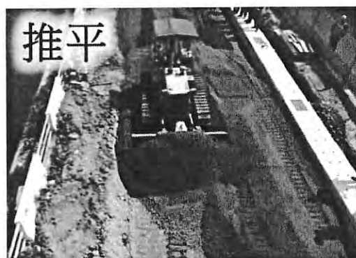
圖 10.5 下料後推平機推平
