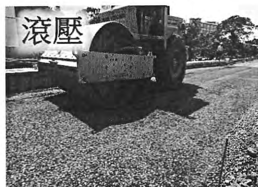
圖 10.7 滾壓機來回滾壓
