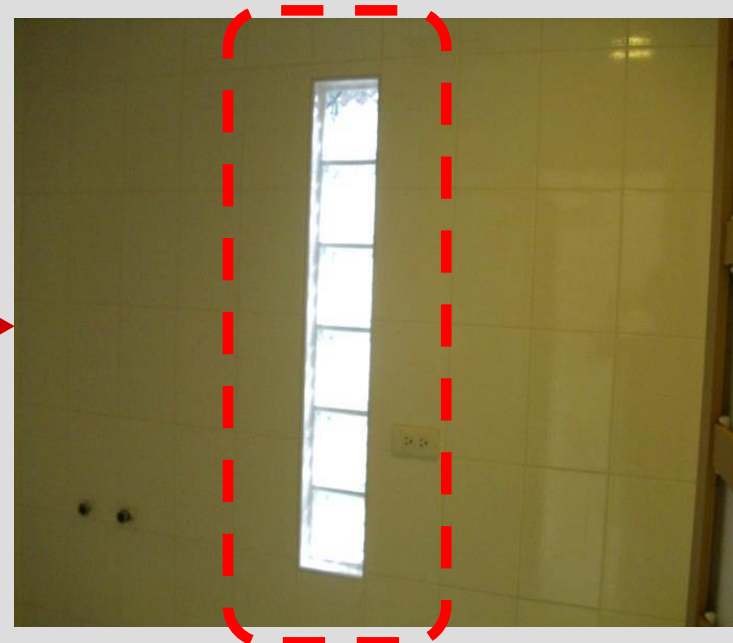
改善後砌1hr防火時效玻璃磚
