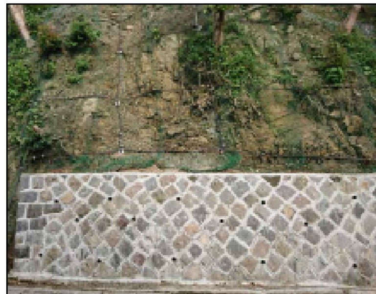
漿砌整形塊石駁坎 (資料來源:攝於士林區平菁街42巷道路下邊坡)
