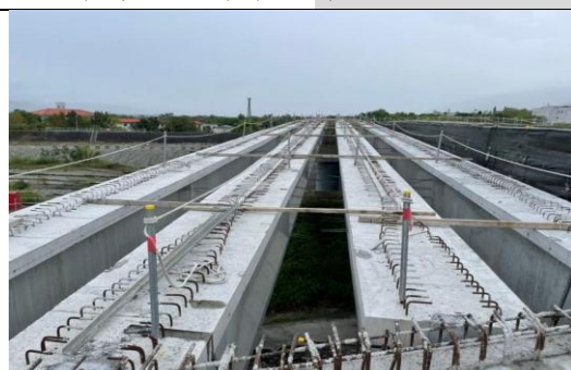
照片 8：吊放後-木料角材橫向連結
