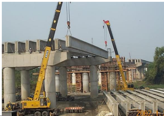
照片 9：預力梁之預鑄與吊放作業
