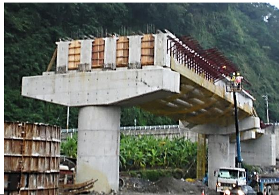
照片 10：預力梁吊放後隔梁施工中
