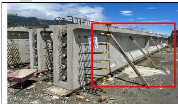
照片 5：吊放前-斜撐可均佈於梁身
