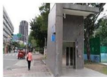
4 大豐公園地下停車電梯出入口
