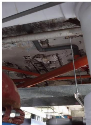
地下室機房頂板現況
