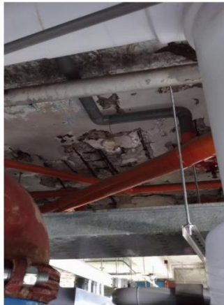
地下室機房頂板現況
