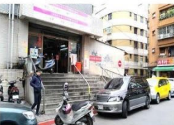
8 新市街 24 巷內市場出入口高低差
